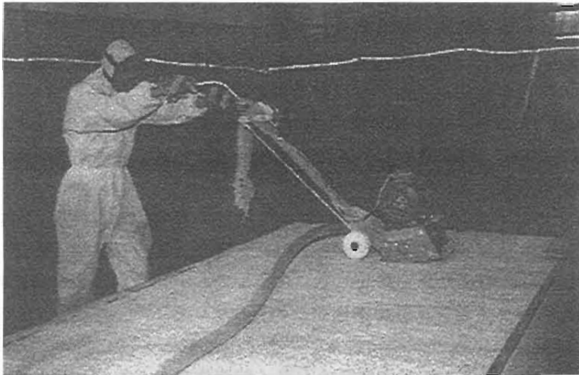
写真4 スキャブラーによるコンクリート除染
